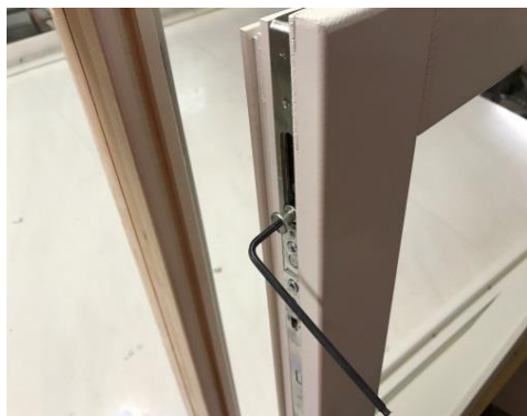
På denne og de følgende 3 bildene vises det hvordan presset mot pakning kan strammes eller slakkes. Verktøy som benyttes er Torx tx15. Skruer du mot klokken økes press mot pakning. Skruer du med klokken økes press mot pakning.
