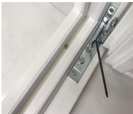
Første bilde viser øverste lukkepunkt på låssiden. Dette bildet viser nedre hengselpunkt. Skruer du mot klokken blir det mer press på pakning. Skruer du med klokken blir det mindre press på pakning.
