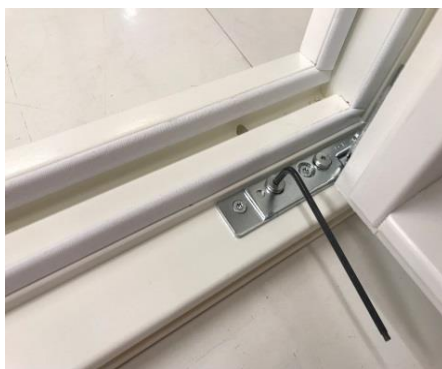
På denne og de 3 neste bildene vises det hvordan klaringer mellom rammen og karm justeres. Skruer du mot klokken flyttes rammen ut fra hengselside, og med klokken flytter rammen mot hengselside.
