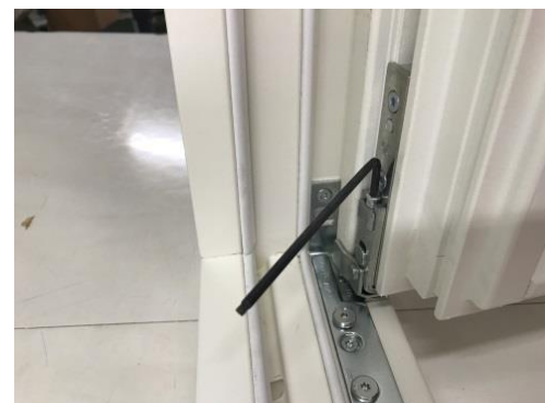
De to første viser justering av nedre hengselpunkt på hengselsiden, sideveis, og opp/ned. Skruer du mot klokken senkes rammen, og med klokken hever rammen.
