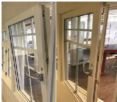
Luftstilling er bunnhengslet og vaskestillingen er sidehengslet.
