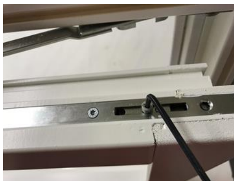
På toppen av rammen i hengselside finnes justeringsskruer for øvre hjørne på hengselsiden. Dreies referansemerket inn mot innside økes presset og dreies det mot utside slakkes presset mot pakning.
